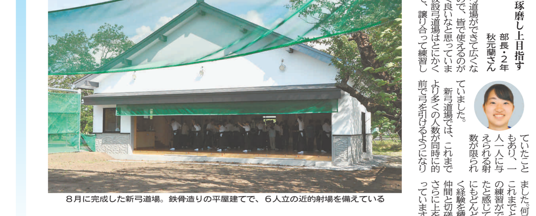
8月に完成した新弓道場。鉄骨造りの平屋建てで、6人立の近的射場を備えている。
